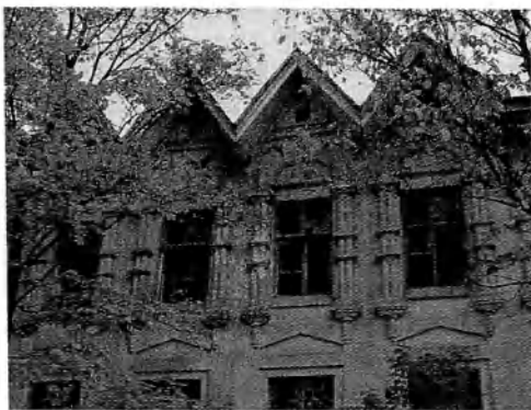
Фрагмент южного фасада
